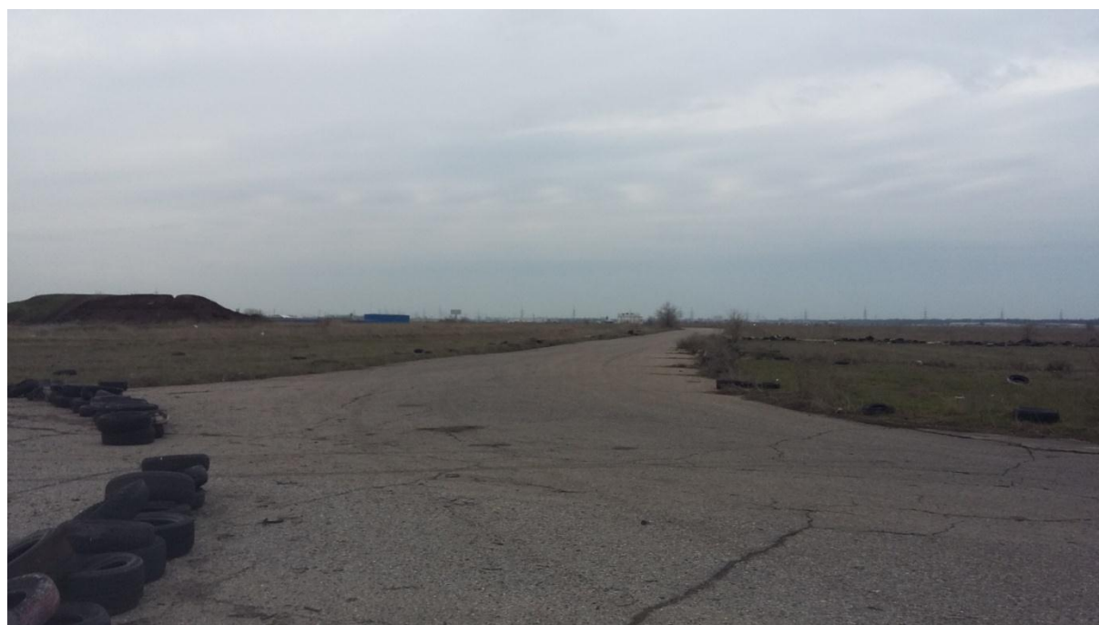
Фото 6. Существующая ситуация. Зброшенняя территория аэропорта "Застава"
