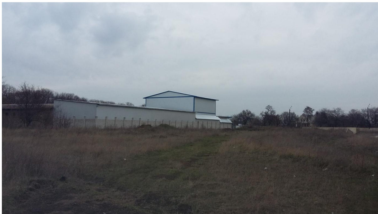
Фото 5. Существующая ситуация. Складские комплексы.
